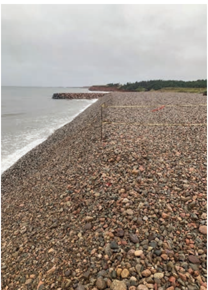
Recharge de plage de Cap-aux-Meules avant la tempête
