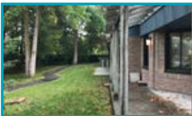
85, rue Adrien-Rouleau Immeuble pour aînés autonomes (6 logements)
