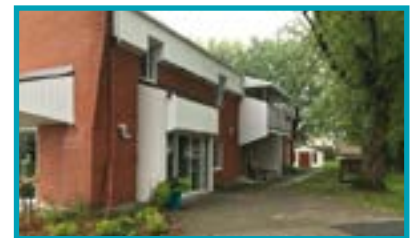
580, route 201 Immeuble pour aînés autonomes (10 logements)
